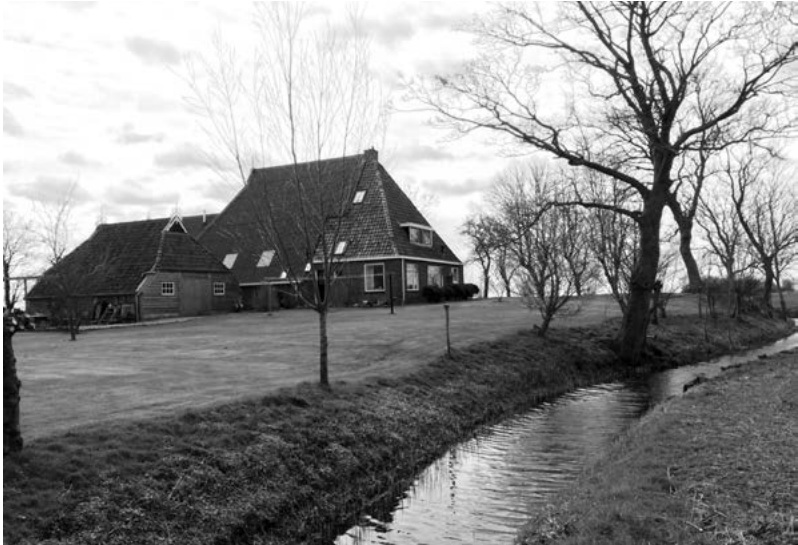
Hibma-sate te Hiaure tegenwoordig, foto J.T. Anema, 2021 De stielp die er nu staat is 20e eeuw; in 1832 stond hier nog een kop-hals-romp. Let op de brede gracht en de verhoogde ligging van het hornleger.
